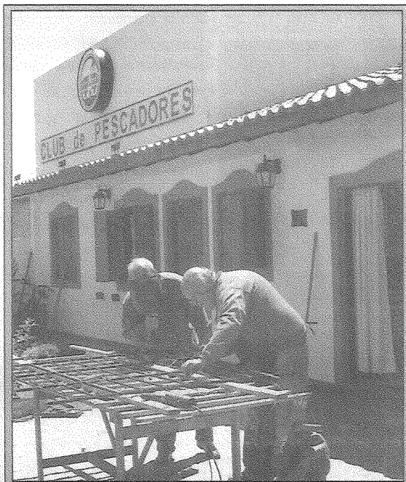
Caruso / Gaudio en plena soldadura
